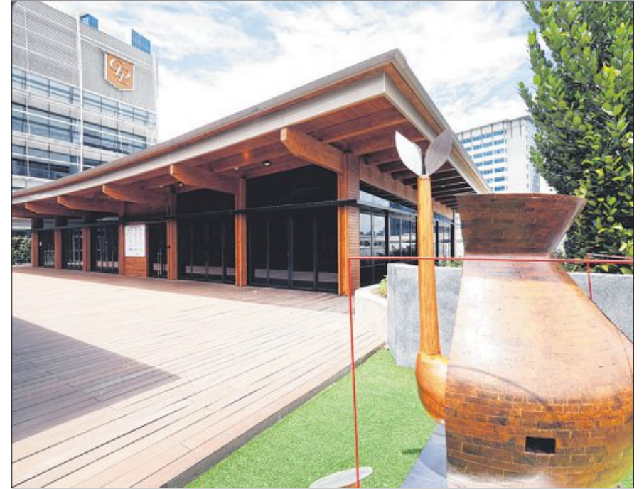
层压胶合实木能带来的好处包括提高施工效率，减少人力，创造灰尘和噪音更少的施工环境，2010年代起更广泛被采用。（邝启聪摄）
