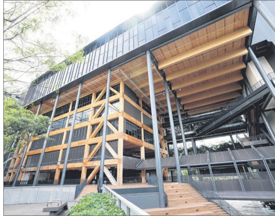
2023年启用的建设局专科学院新楼采用了层压胶合实木，最初出现发霉迹象，但通过调整冷气便很快解决了问题。（邝启聪摄）
